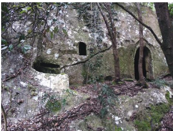
Fig. 3 – Prospetto esterno della chiesa. Da notare la canaletta che raccoglie l'acqua piovana per convogliarla nella cisterna (foto R. Paolicelli)
